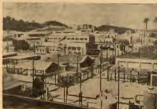
Заводи за електромагнитно отделение изотопите на урана.
